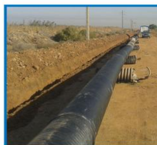
اجرای خطوط لوله (پلی اتیلنی و بتنی)
