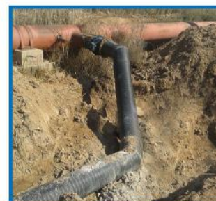
اجرای خطوط لوله (پلی اتیلنی و بتنی)
